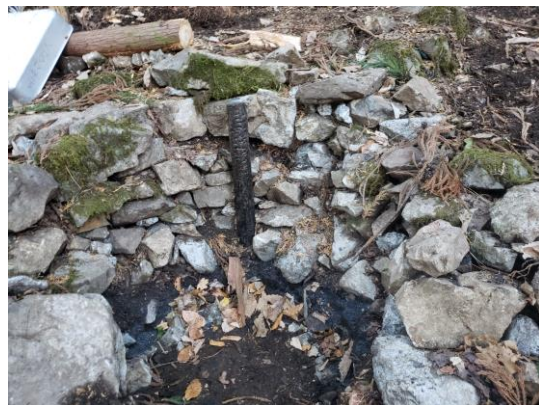
今回作った石積み。 谷に築いた石積み水が引き付け、湧き出した 水はまた地表に浸透していく場所となります。
