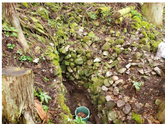
水を引くために昔の人が谷を掘り、石積み 築いた箇所。 谷の奥の方には当時の石積みが残っています。
