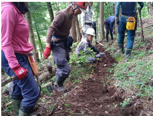
シカ道のように、等高線に沿って歩道を引き、断面は水平に保つ、その後雨滴から土壌面を保護するため落ち葉などで被覆。
