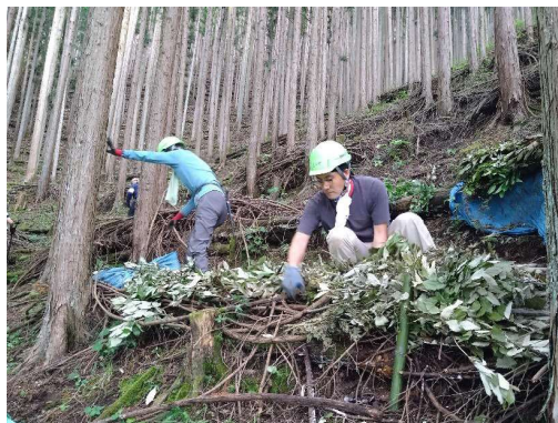
土壌が流れやすい場所には、枝がらみの土留めを行う。
