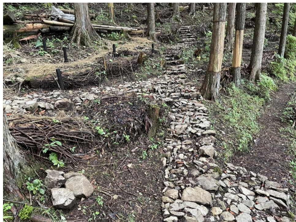
50人が2mずつ作業するだけでも100mにわたる石畳が完成しました。入口から続く道は石畳の道に生まれ変わりました。この道は、水源の森の幹線道路にあたり、人がよく通る道であることから、今回施工した石畳の他、藁や落ち葉で地面を荒らさないよう工夫しています。
