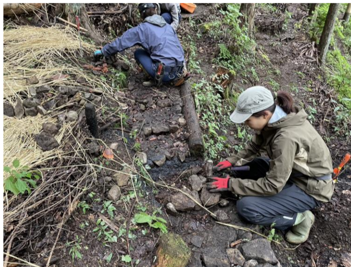
傾斜のある道は、階段状に段を切り、地表を水平にする。今回は、段差になるところを石畳・石積みで安定させる。
