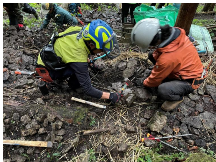
道の地表面に炭・燻炭と落ち葉を敷いて、その上に石畳を施す。
